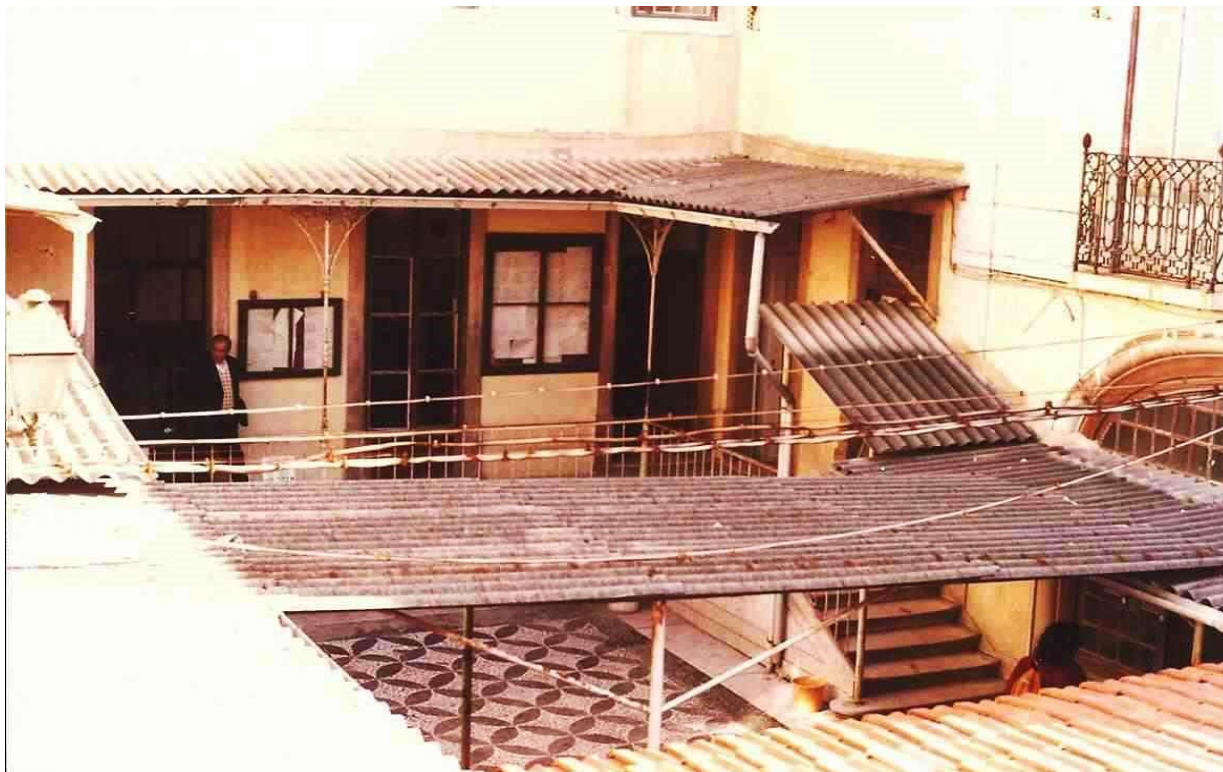
Edifício Buenos Aires
